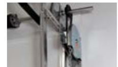
Grúa de cadena manual con un sistema de freno interno que brinda un descenso controlado para las puertas enrollables.
