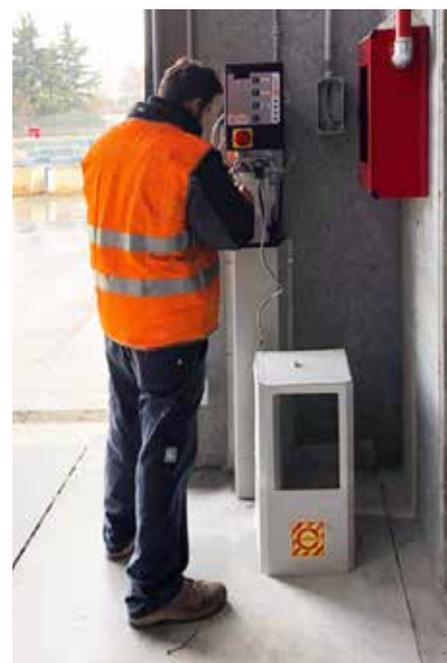
La inspección por la manutención se reduce a la simple verificación del nivel de aceite dentro de la consola colgada en la pared aproximadamente 1,5 m H del suelo.
